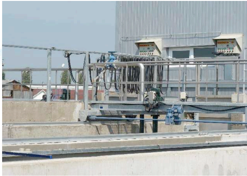
Figura 2.3. Relevu foto deznisipator cu separator de grăsimi.
