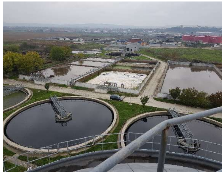
Figura 2.5. Relevu foto bioreactor cu nămol activat.
