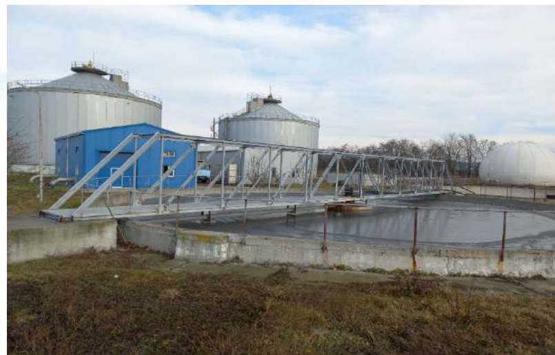
Figura 2.8. Relevu foto îngroșător gravitațional.
